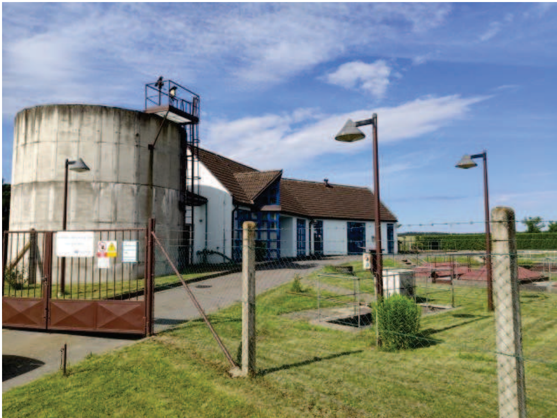
Obr. 2: ČOV Nové Veselí
