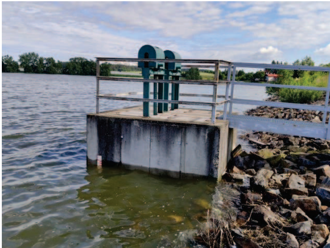
Obr. 16: Výpustní objekt na Veselském rybníku
