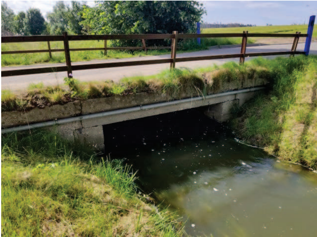
Obr. 7: Mostek u požární nádrže
