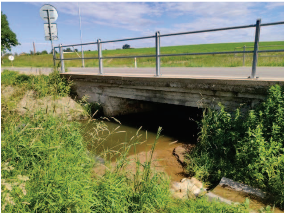
Obr. 6: Most na silnici III/35331
